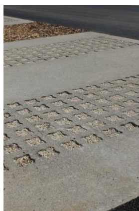
Béton alvéolaire avec un remplissage gravillonné
