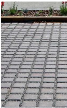
Pavés à joints élargis avec un remplissage gravillonné
