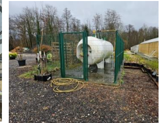
Cuve à fioul pour chauffage d'appoint
