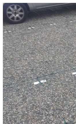
Les dalles alvéolées avec un remplissage gravillonné
