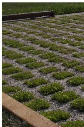
Béton alvéolaire avec un remplissage végétalisé
