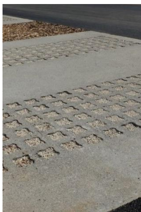
Béton alvéolaire avec un remplissage gravillonné
