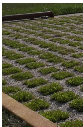
Béton alvéolaire avec un remplissage végétalisé
