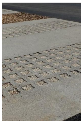
Béton alvéolaire avec un remplissage gravillonné
