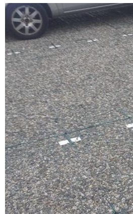
Les dalles alvéolées avec un remplissage gravillonné
