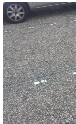
Les dalles alvéolées avec un remplissage gravillonné
