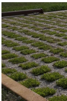
Béton alvéolaire avec un remplissage végétalisé
