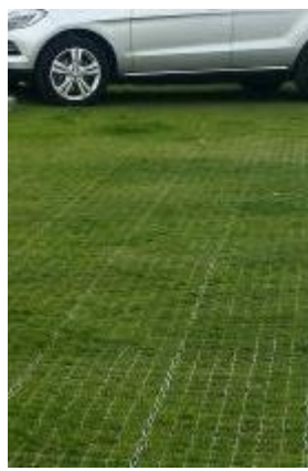
Les dalles alvéolées avec un remplissage végétalisé
