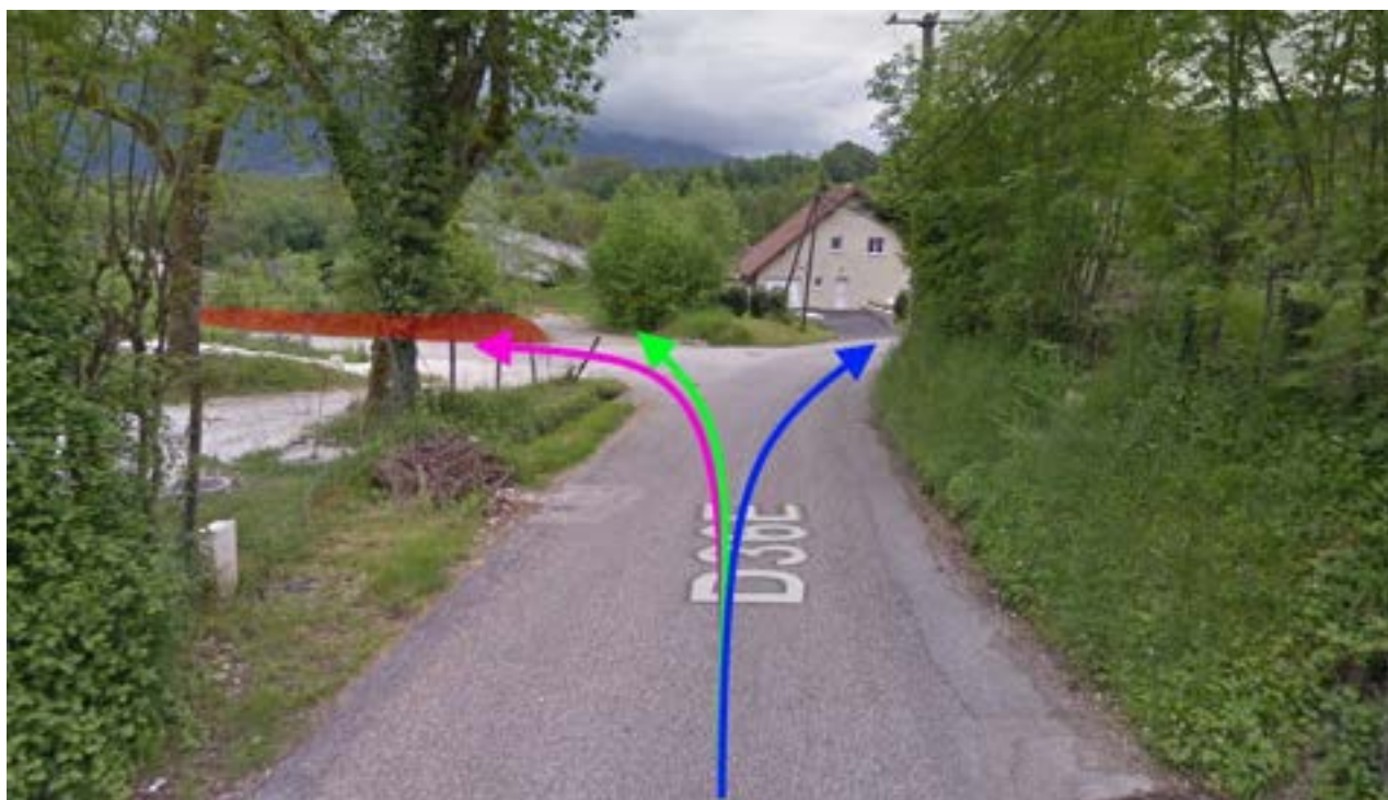
Photo 5 : cheminement des débordements du ruisseau du Serpinet à l'amont du croisement de la route de la Drevetière (RD 36E) et de la rue du Serpinet (à gauche). © 2022 Google.
