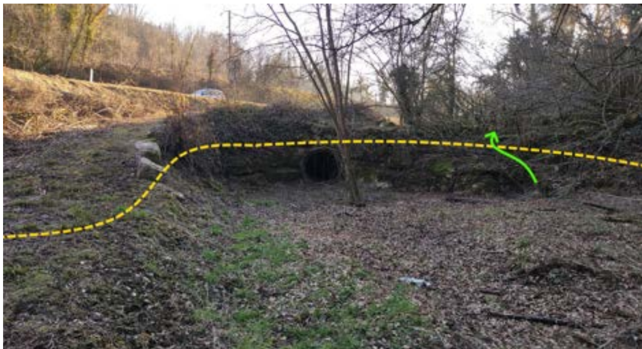
Photos 6: Ouvrage à l'amont de la RD 921 au lieu-dit Rochaux
